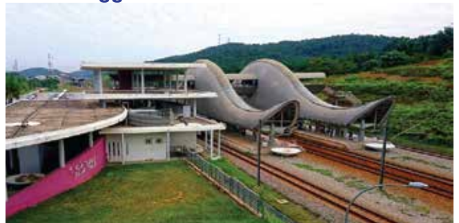
Salak Tinggi ERL Station
